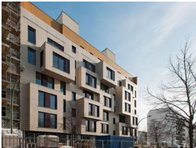
Die Fenster dreifach verglast, die Holzfassade mit Zellulose gedämmt. Das Nullemissionshaus Boyenstraße in Mitte kommt mit 16 Kilowattstunden Heizwärme pro Jahr und Quadratmeter... - FOTO: SVEAPIETSCHMANN.DE
